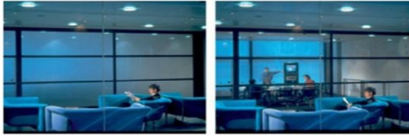
شكل رقم (٢) توضح استخدام الخامات الكروموكهربية في القواطع الزجاجية، حيث نرى قدرتها على حجب الأنشطة المتنوعة بتغيير حالتها من الشفافية إلى الامتار.
